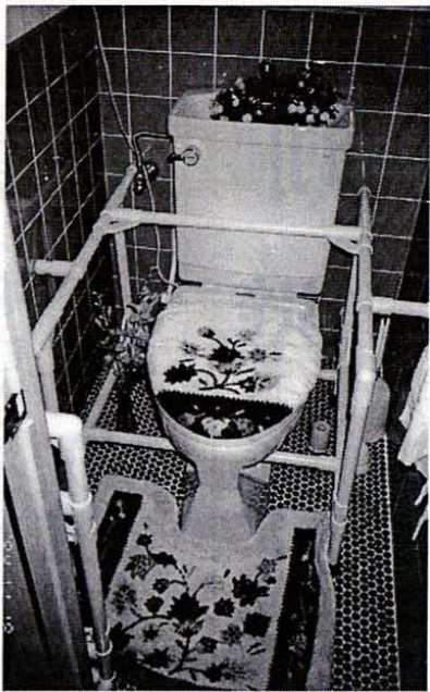
レクターパイプで手すり
