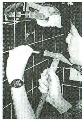
てすり取り付け作業中
