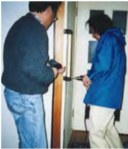
慣れた手つきで手すりを取りつけ
